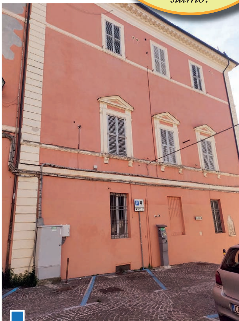
La facciata laterale di Palazzo Chiavelli
